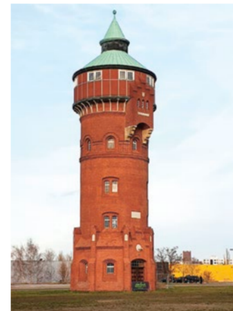
Das Gelände des ehemaligen Gaswerks Mariendorf – heutiger Marienpark, Foto: Marina Heimann
