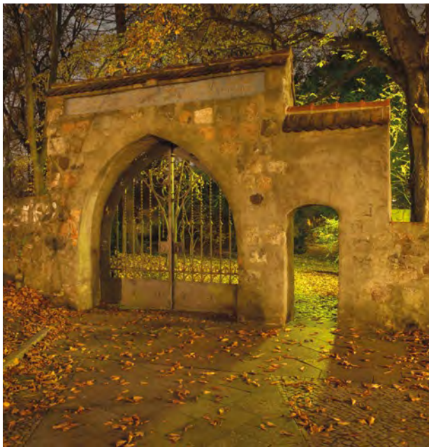
Das Kirchhofportal der Dorfkirche Alt-Tempelhof Foto: Michael Wartmann, 2012 Dunkelführungen mit Marion Feise | siehe S. 6, 7 und 9
